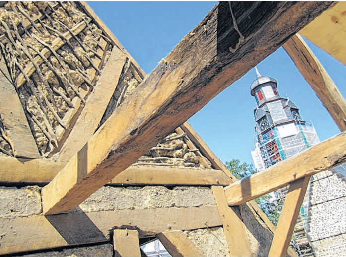
Interessante Perspektive bei abgedecktem Dach.
