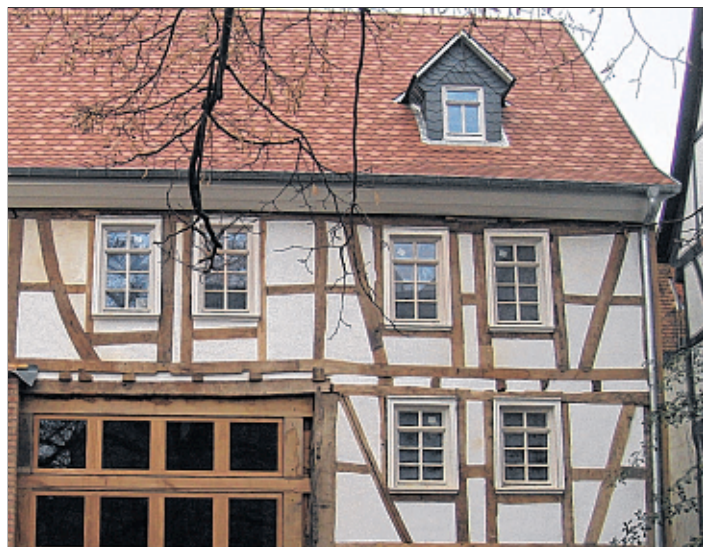
Ein Blick auf die Fassade wird schon einmal gewährt...
